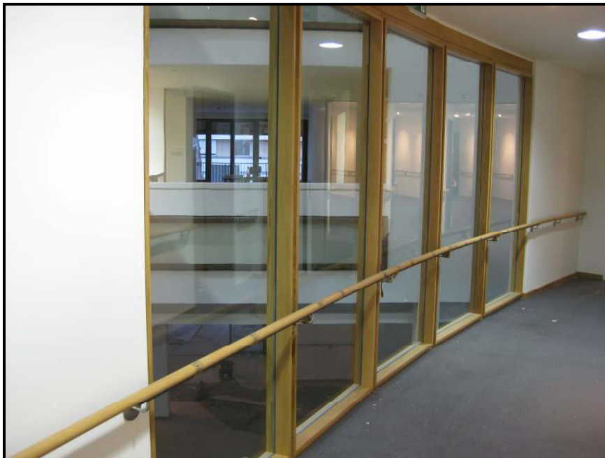
Absturzsichernde Brandschutzverglasung mit vorgesetztem Handlauf (Brandschutzverglasung mit absturzsichernder Funktion nach Kategorie C3)
