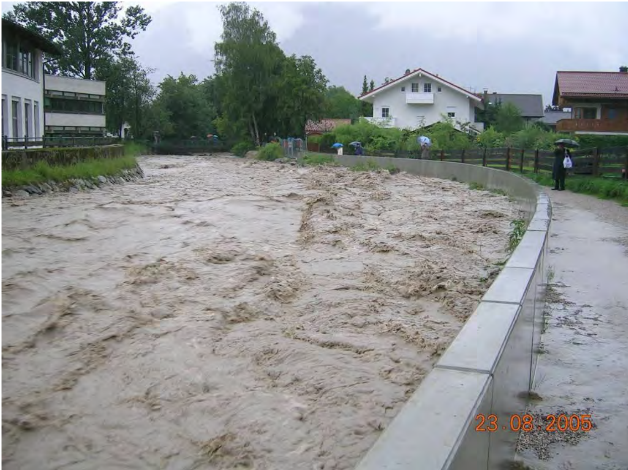
Fertigteil Winkelstützwand an der Partnach in GAP (Lkr. GAP, 2005)
