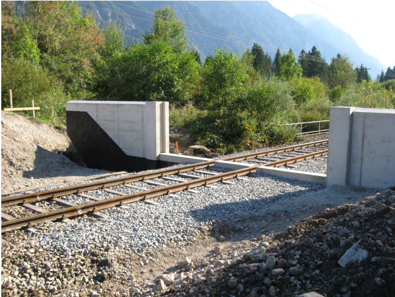
Damm balkenverschluss an der Loisach in Eschenlohe (Lkr. GAP, 2010)
