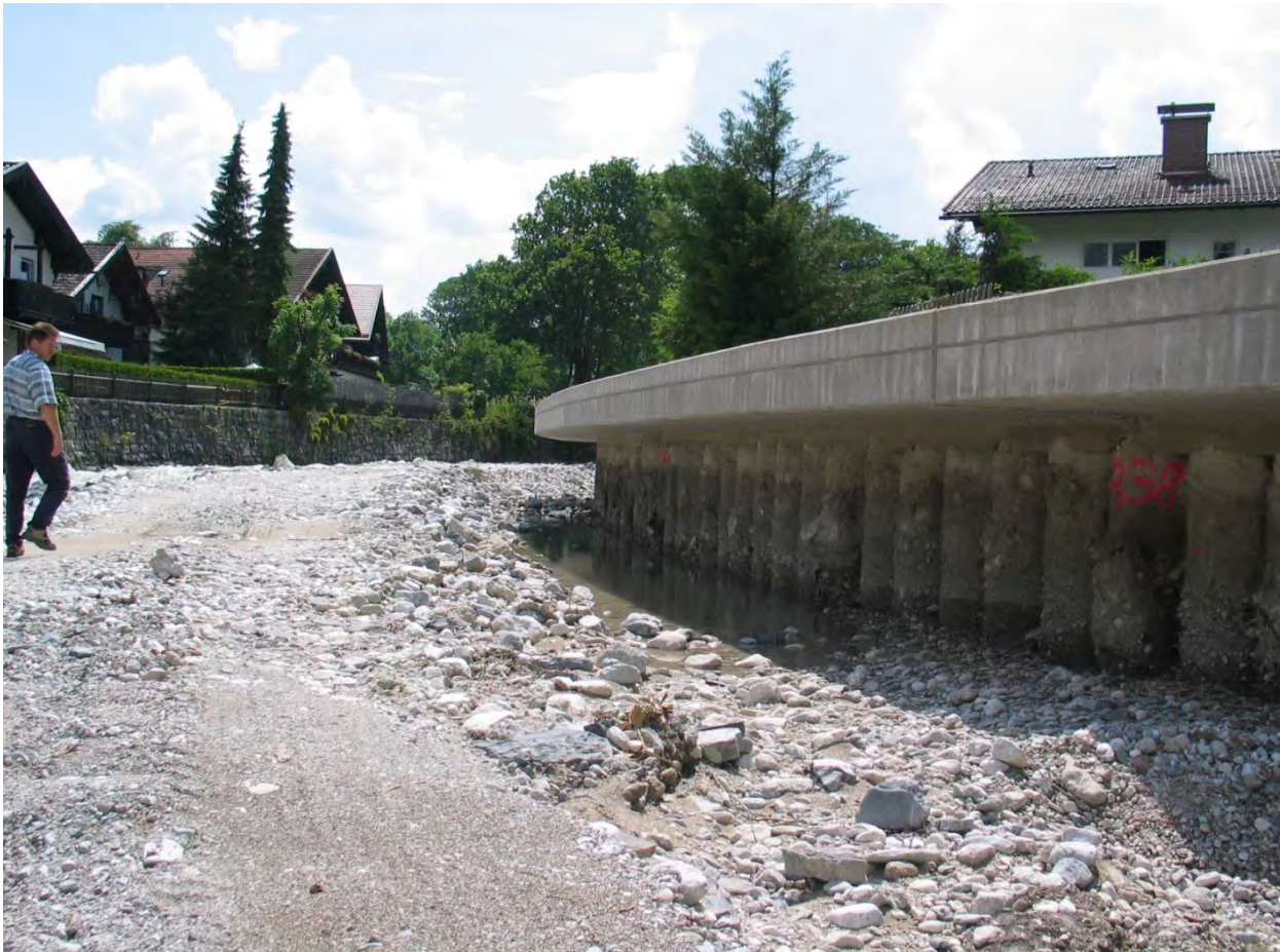
Bohrpfahlwand mit auskragendem Gehweg an der Partnach in GAP (Lkr. GAP, 2007)
