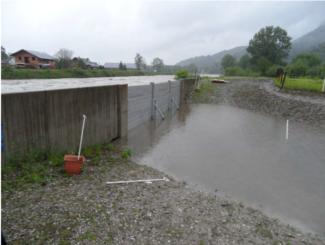
Damm balkenverschluss an der Loisach in Eschenlohe (Lkr. GAP, 2013)
