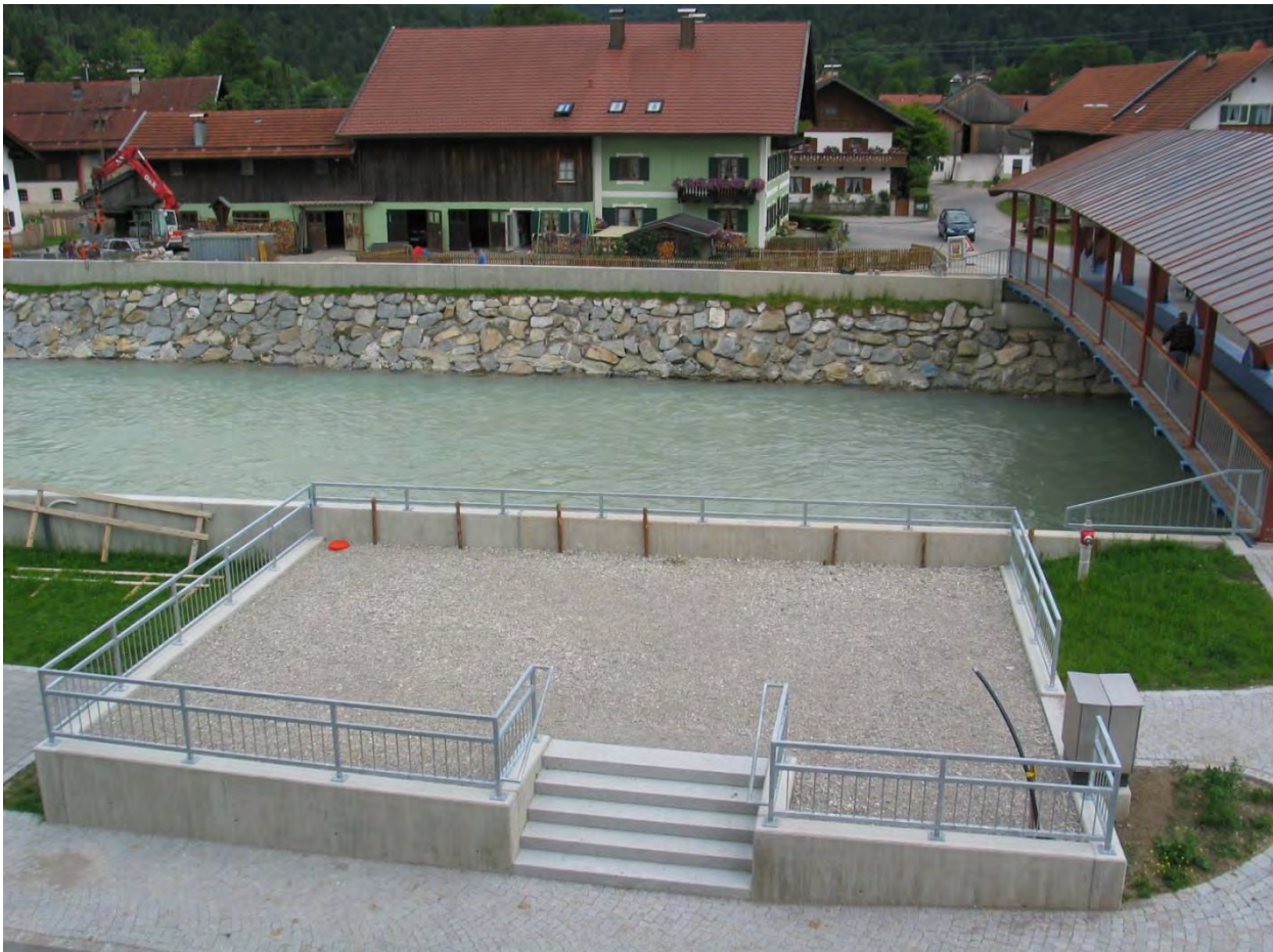
Ortbeton Winkelstützwand HWS an der Loisach in Eschenlohe (Lkr. GAP, 2006)
