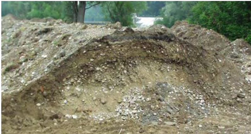
Flussdeich an der Mangfall bei Bad Aibling (Lkr. Rosenheim) Baujahr 1928, erhöht 1958)
